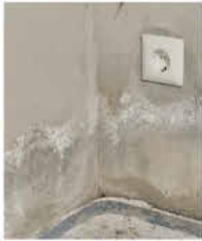
defekte Horizontalsperre
